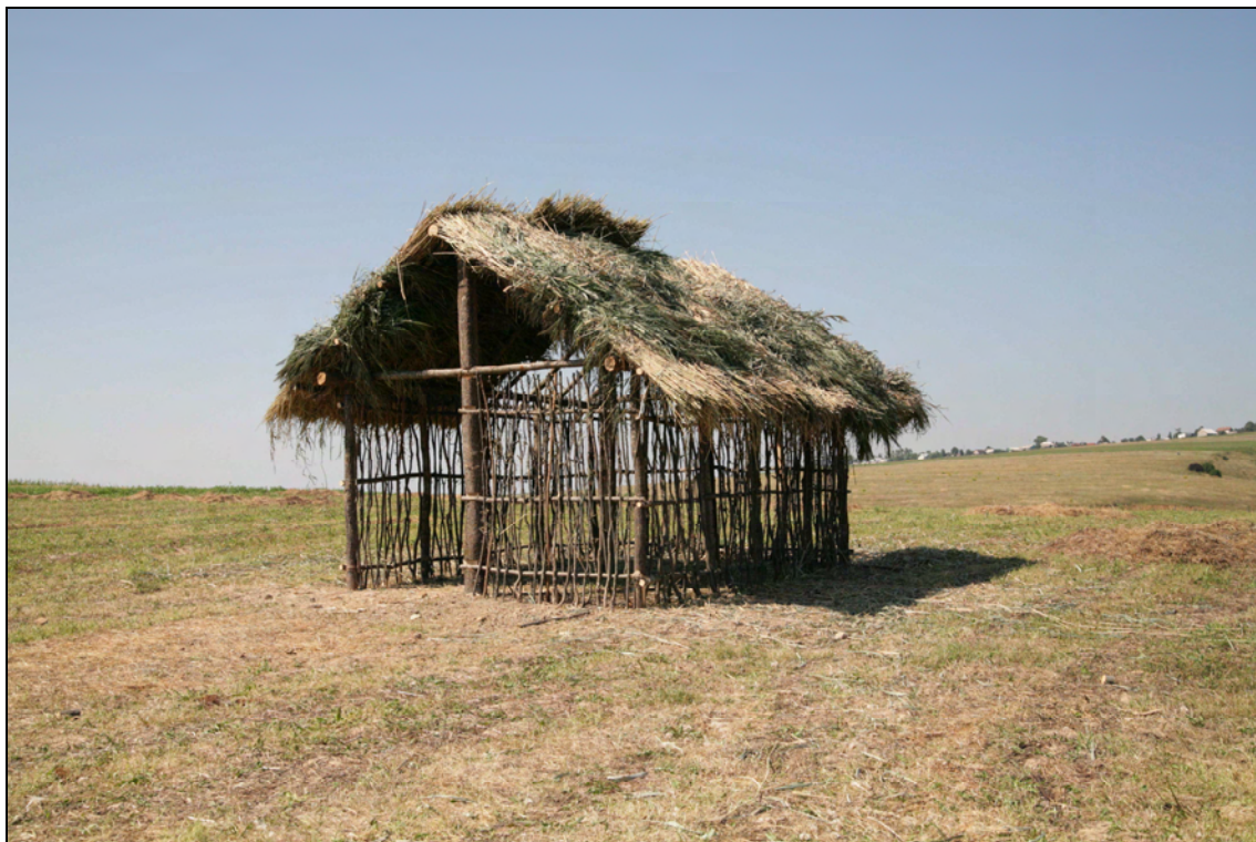
Foto 6. „Casa nordului” în construcție. Zvoriștea 2008. “The house of North” in construction. Zvoriștea 2008.
