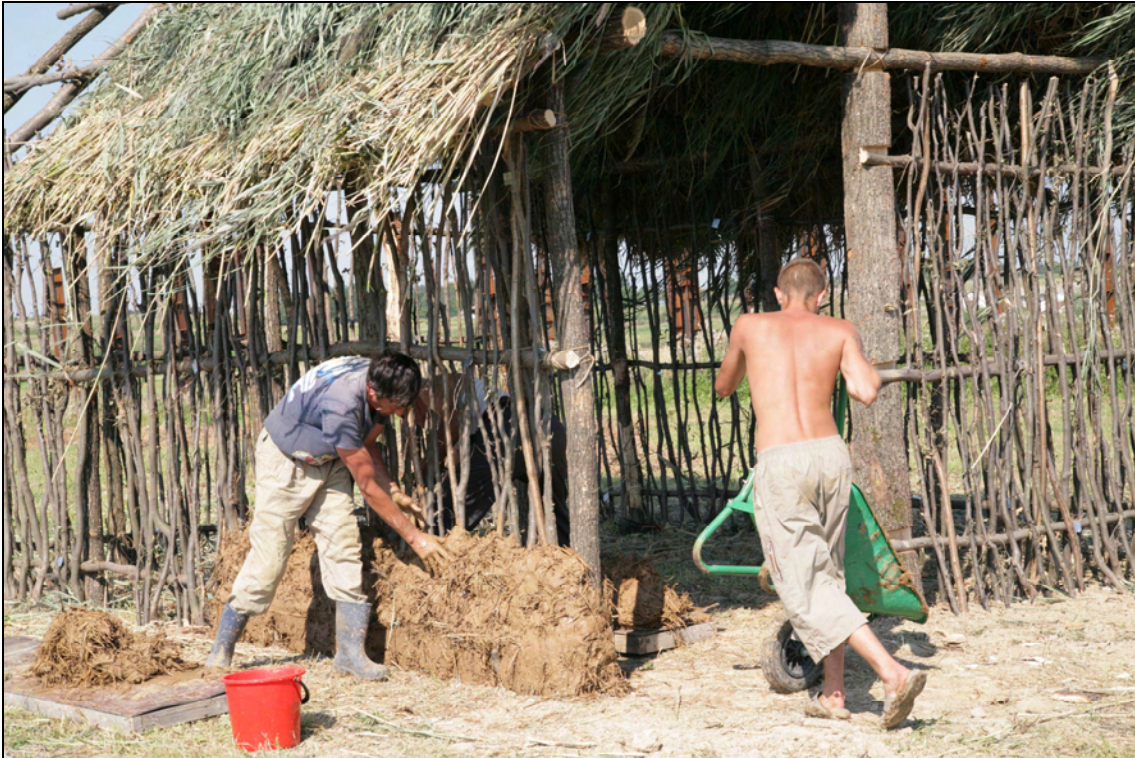
Foto 7. „Casa nordului” în construcție. Zvoriștea 2008. “The house of North” in construction. Zvoriștea 2008.
